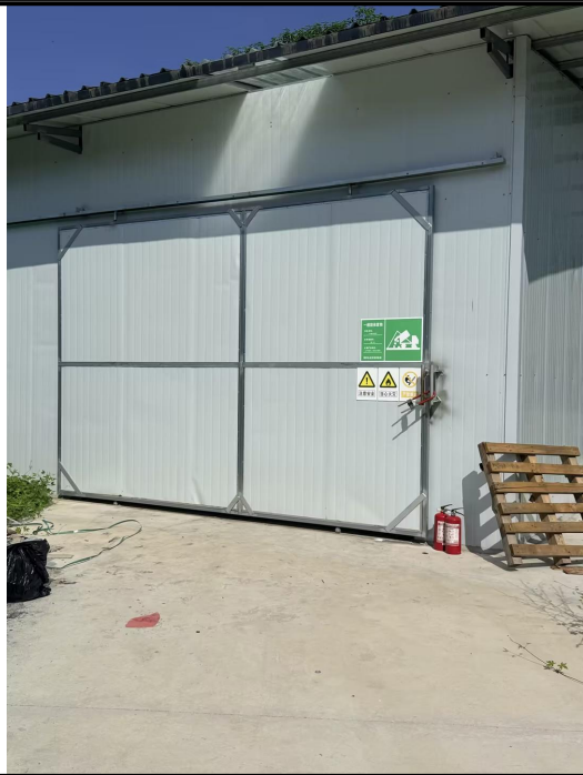
一般固废间外部
