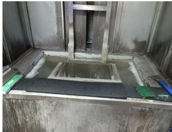
去树脂条工序清洗槽
